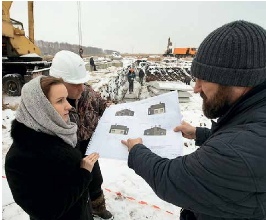
На стройплощадке «Новых берегов»
