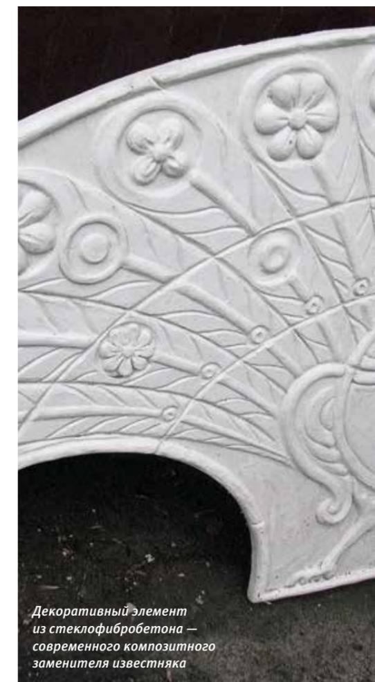
Декоративный элемент из стеклофибробетона — современного композитного заменителя известняка
