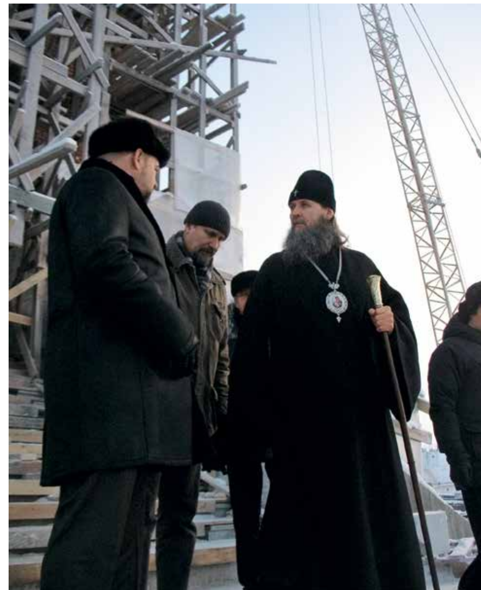
Рабочая планерка на ступенях строящегося Михаило-Архангельского кафедрального собора
